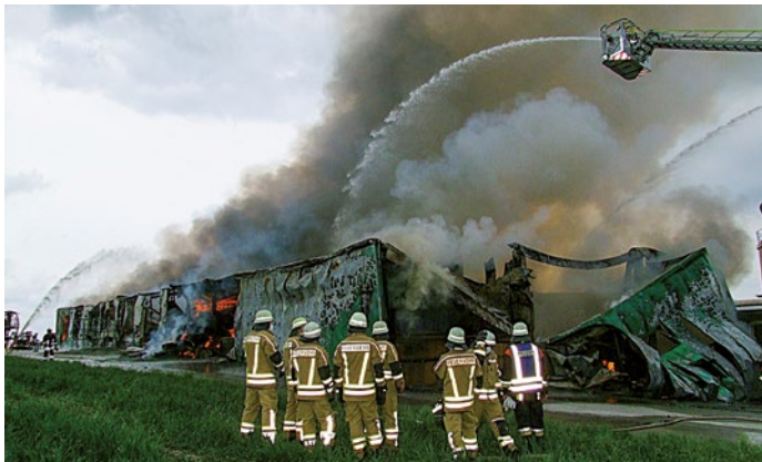
Hitzeinwirkung: Die Statik hält nicht mehr stand, die Halle stürzt ein.
